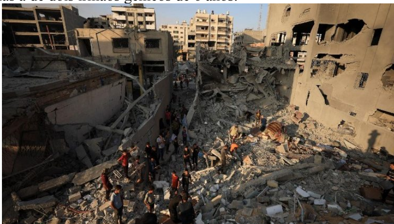
Pessoas sobre os destroços de um prédio residencial atacado neste domingo (14) na Cidade de Gaza.
